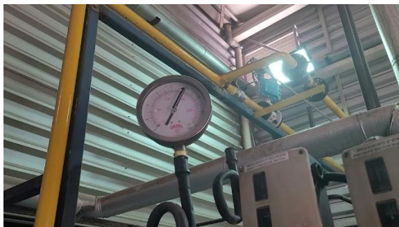
PRESOSTATOS DE LA CALDERA DE VAPOR
