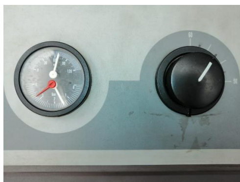
CONTROL DE PRESIÓN CIRCUITO DE CALEFACCION
