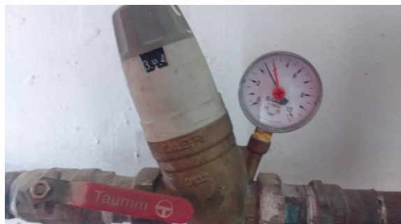
CONTROL DE PRESIÓN CIRCUITO DE CALEFACCION
