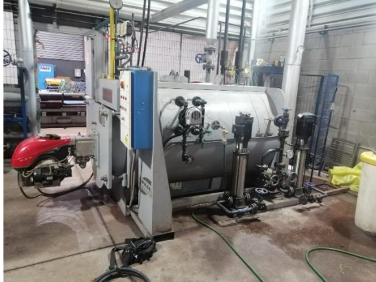
CALDERA DE VAPOR, COMPONENTES Y ACCESORIOS
