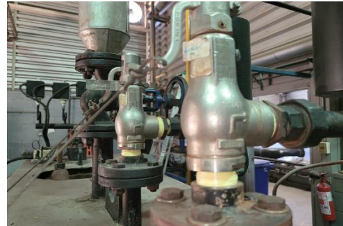
PURGAS DE VAPOR DE LA CALDERA DE VAPOR
